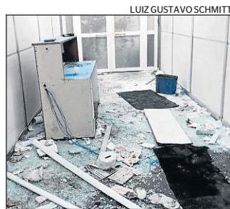
➤ Local ficou bem danificado
